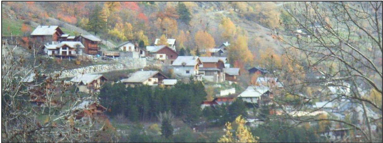
Vue d'ensemble du village des Pananches
