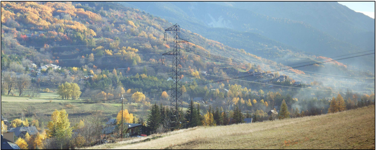
Versant Nord avec vue sur les Pananches
