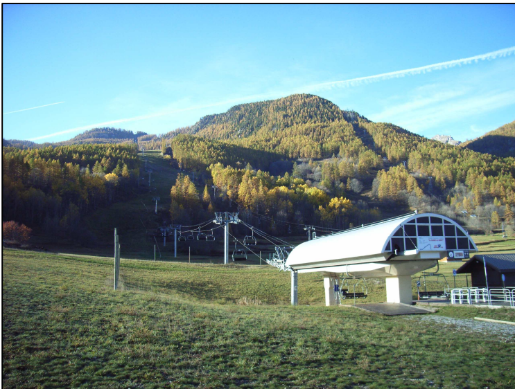
Versant sud avec une vue sur une remontée mécanique et vers les sommets (L'Eychauda)
