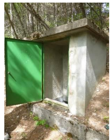
Captage du Bessey
