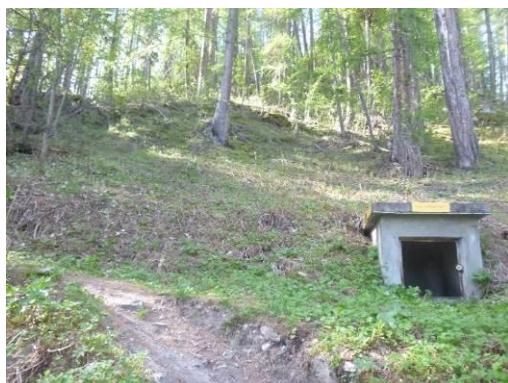
◆ Captage de Gratar
