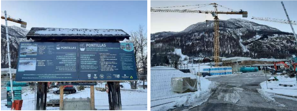
Travaux pour la création d'un bâtiment avec services attenants à la gare de départ du Pontillas
