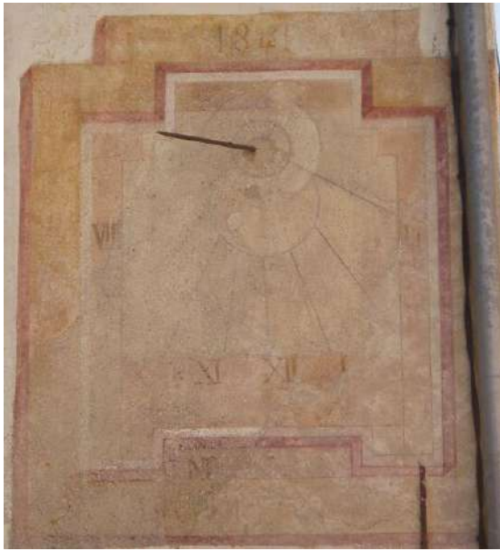
cadran dégradé, fantaisiste, gravé et peint sur enduit, dégradé, lignes chiffrées dans bandeaux, devise effacée, style linéaire horizontal, daté 1841.
