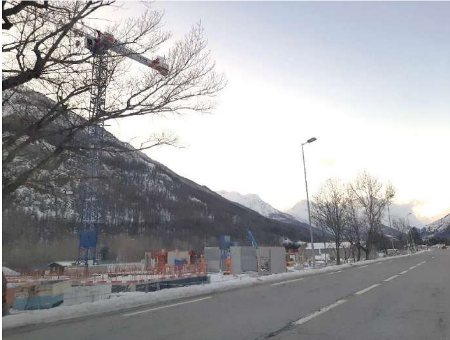
Vue sur les travaux en cours sur le secteur 1
