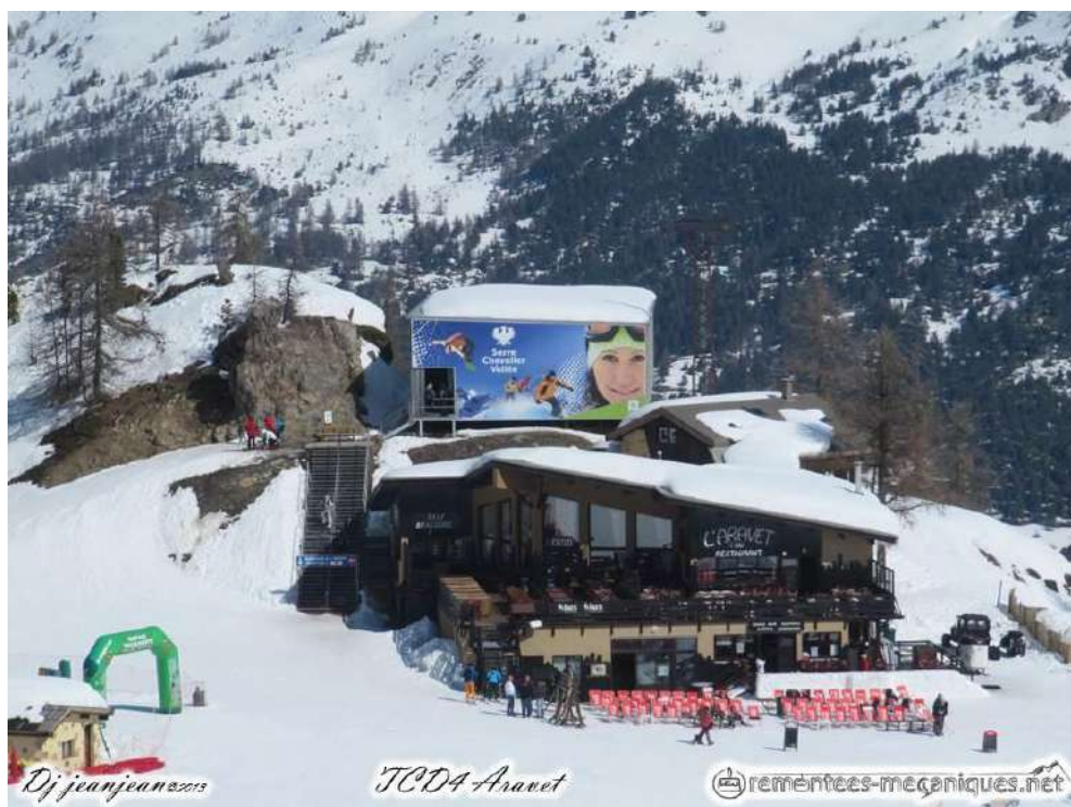
Photographie de la gare d'arrivée de l'Aravet depuis le sud de la commune
