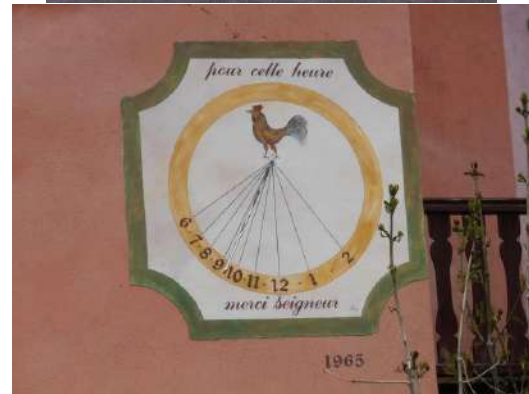
adran déclinant du matin, gravé et peint sur enduit, fines lignes chiffrées dans couronne, devise, signature, style polaire.
