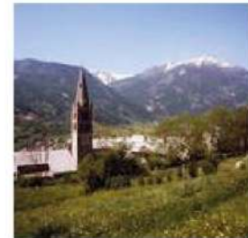
Eglise paroissiale Saint-Marcellin
