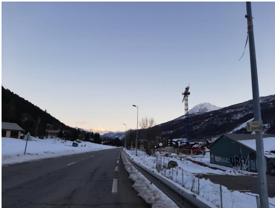
Vue sur le secteur d'OAP depuis la RD1091, travaux en cours sur le secteur 1 (décembre 2023)
