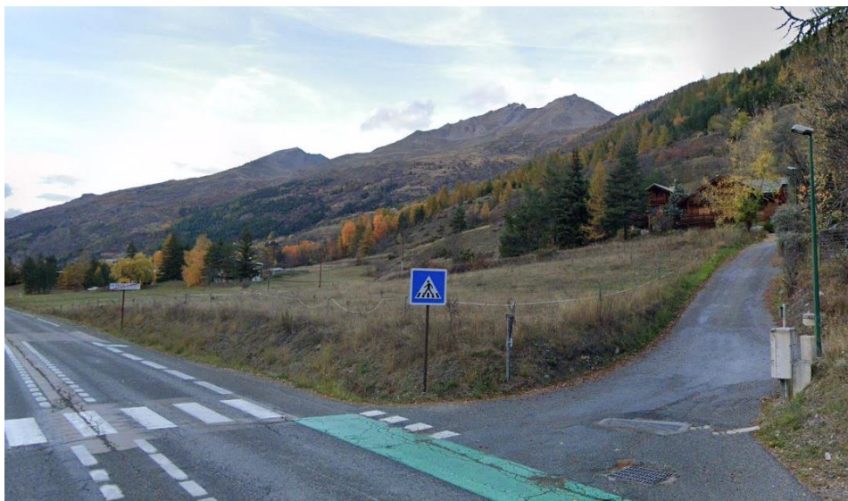
Vue sur le secteur du Pilon depuis la route départementale en direction de l'ouest Source : Google Street View – 2019
