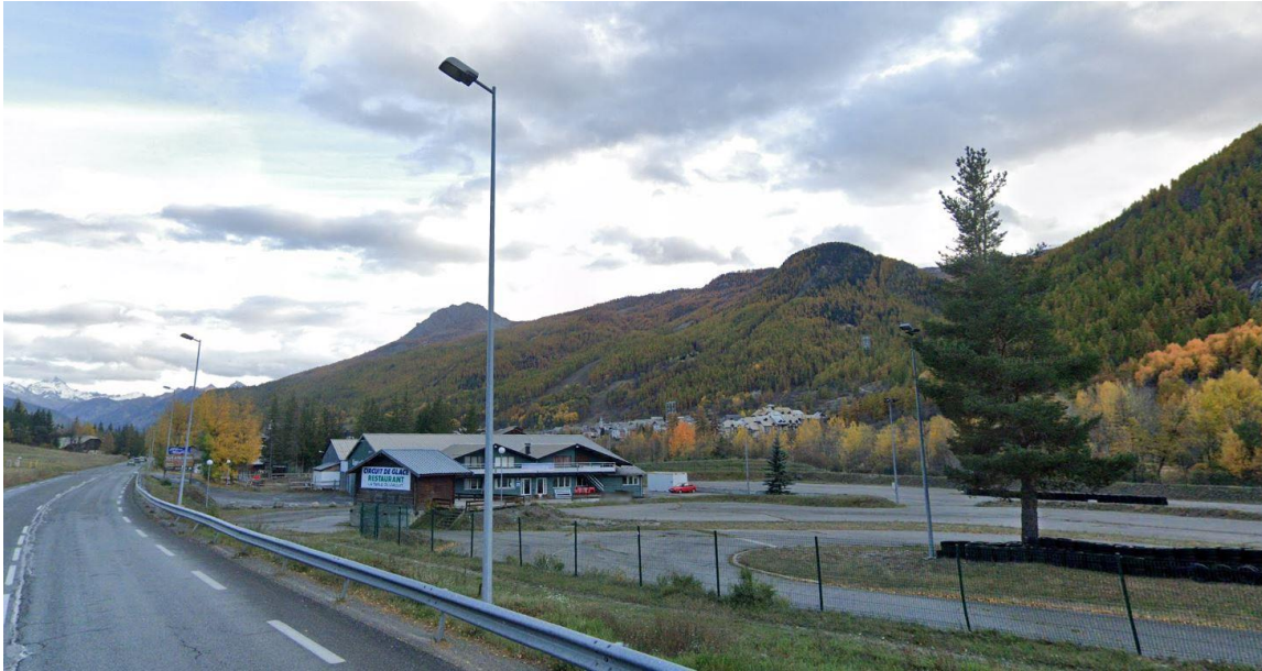
Vue sur le secteur d'OAP depuis la RD1091, avant travaux
