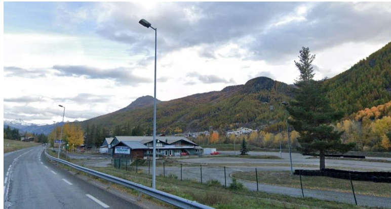
Vue sur le secteur d'OAP depuis la RD1091, avant travaux
