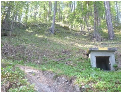
◆ Captage de Gratar
