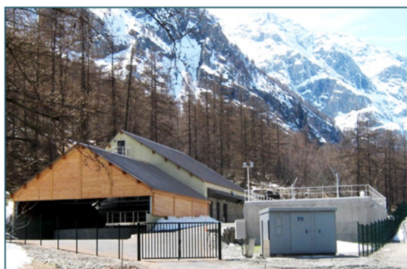
La station d'épuration du Pays de la Meije
